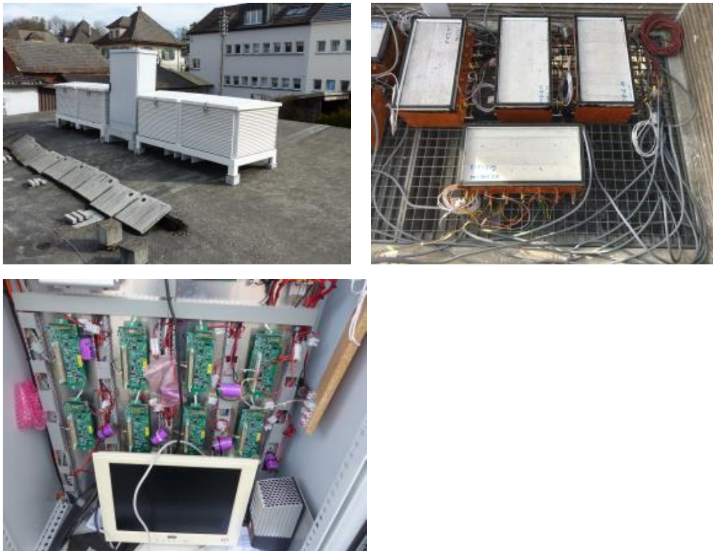
Abb. 21 Stevenson-Screens auf dem Dach der Garagen der TFB AG mit dem Schrank für das Monitoring (oben links) und eingelagerte Prüfkörper (oben rechts) und Blick in den Messschrank (unten).
